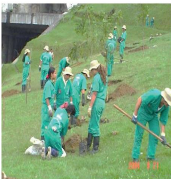
Obras de estabilidad y control de la erosión (revegetación, reforestación, disminución de la pendiente). Fuente: Cardona et al., 2020.
