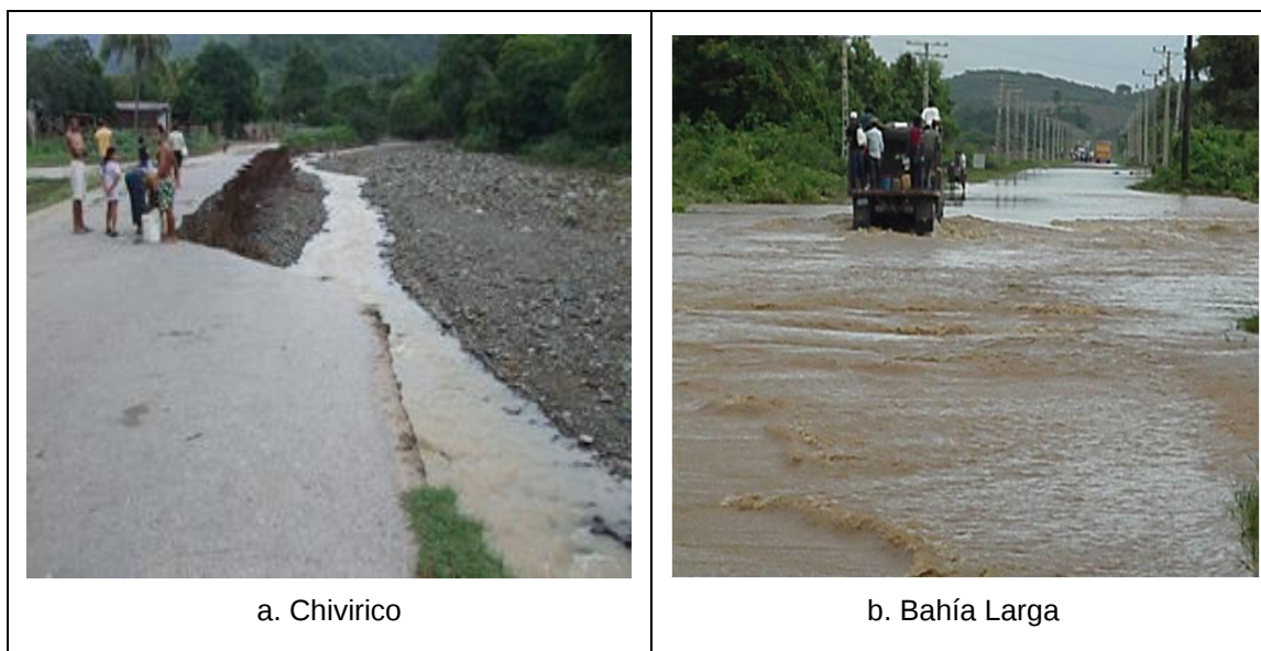
Figura 10. Destrucción del vial (a) e interrupción de la circulación por la carretera principal por la crecida del río Sevilla (b). Fotos: Euclides Fornaris Gómez (Tomadas de Colectivo de Autores, 2022).
