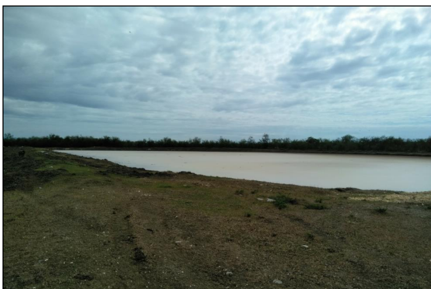
Figura 9. Laguna de Oxidación para los residuales líquidos del CAI Urbano Noris. Los residuales son muy agresivos por su alto contenido en alcohol, se observa el agua de color blanquecino.
