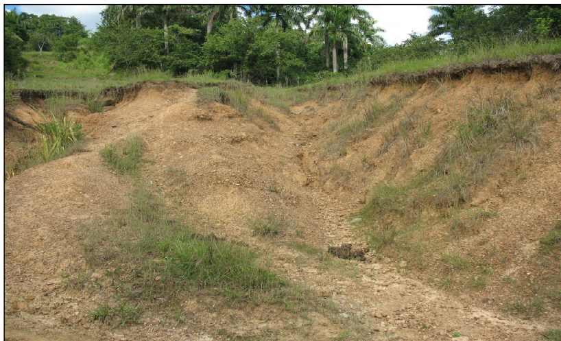
Foto 4. Proceso erosivo como consecuencia de un camino abandonado
