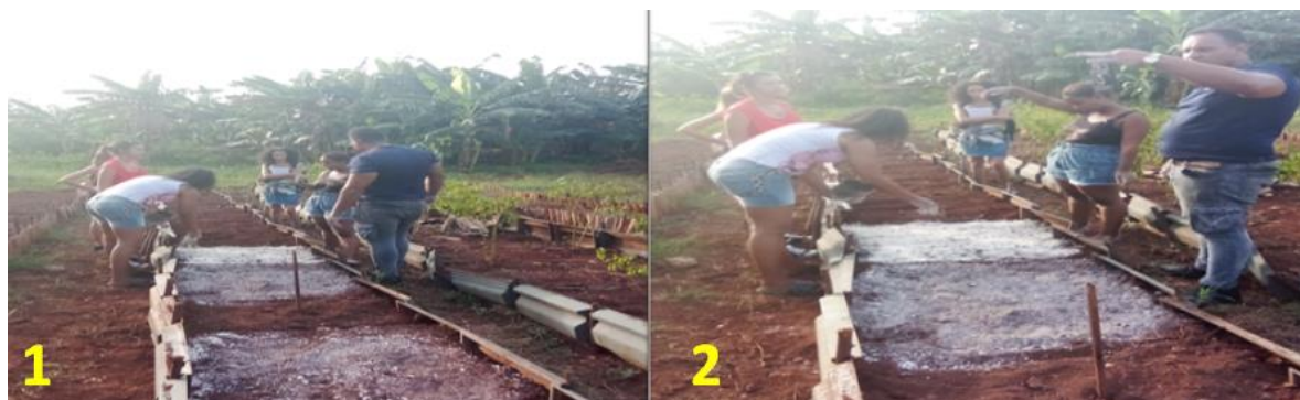
Figura 11: División del cantero para la aplicación del mejorador de suelo.
