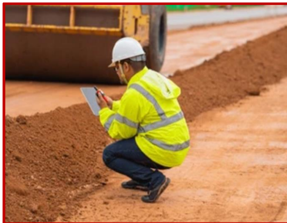
Figura 14. Construcción del terraplén de prueba.
