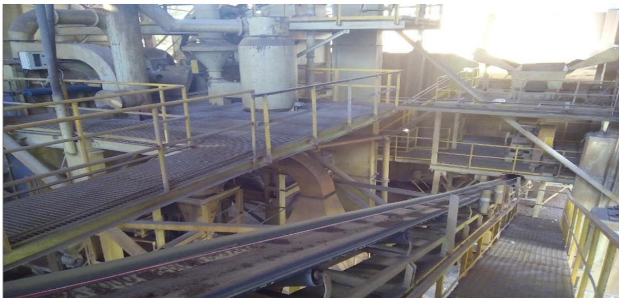
**Figura 13.** Bandas transportadoras para el traslado de los rechazos serpentínicos hasta la trituradora.
