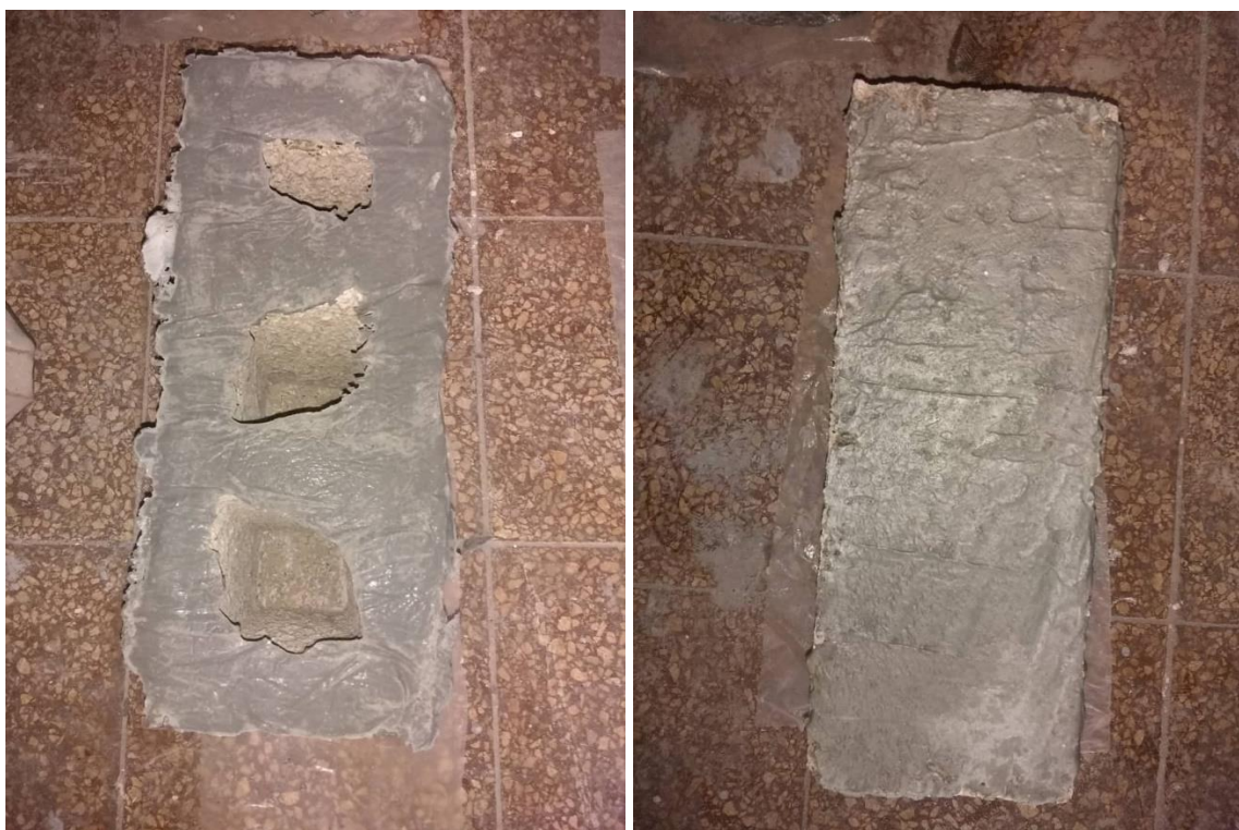
Figura 2.11. Recubrimiento de los bordes del bloque con una capa de cemento P-35
