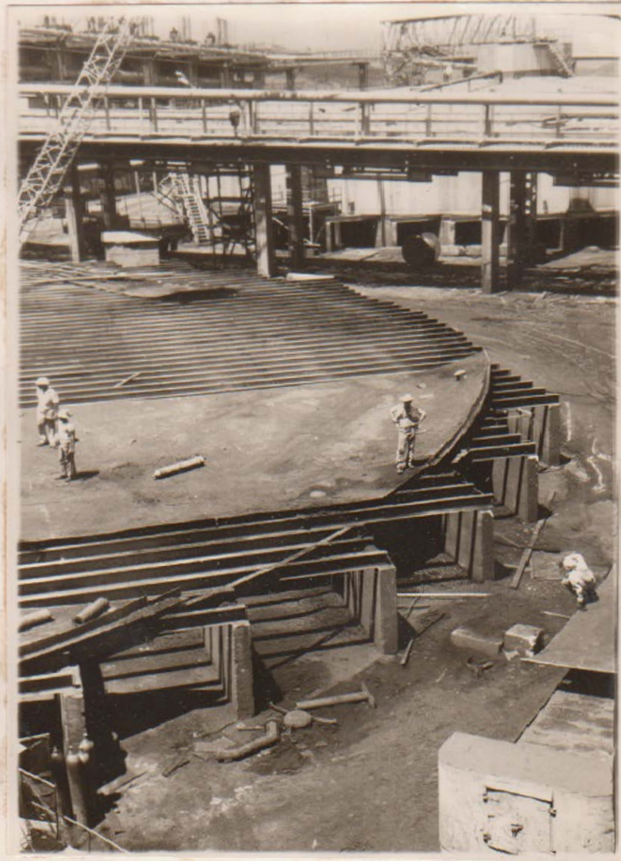
Fig. 3a. Fase de desmantelamiento del sedimentador 109 B.
