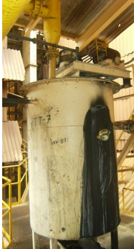
• Figura 4: Turboaerador TT-7
