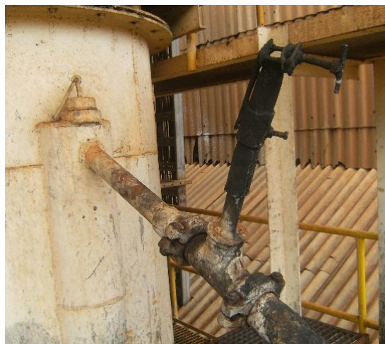
Figura 5: Punto de muestreo de la pulpa sin magnetizar
