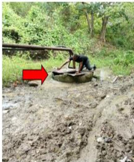
**Figura 6.** Pozo criollo muestreado con tapa no hermética.
