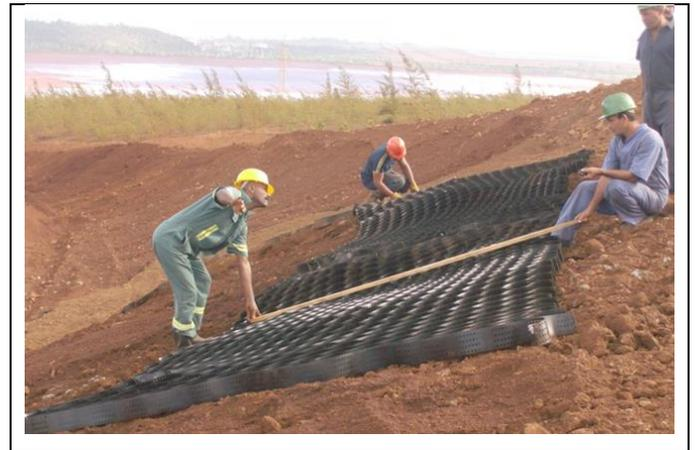
**Figura 4.24** Mantenimiento a las geoceldas colocadas en diferentes áreas del sector de estudio.
