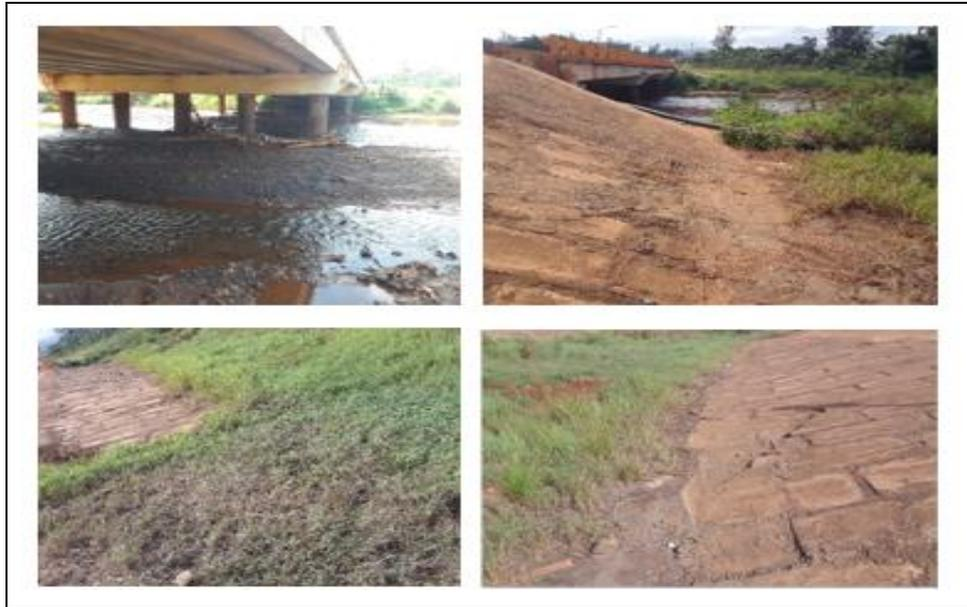
**Figura 4.2** Métodos de bloques premoldeados y geoceldas en protección de riberas.
