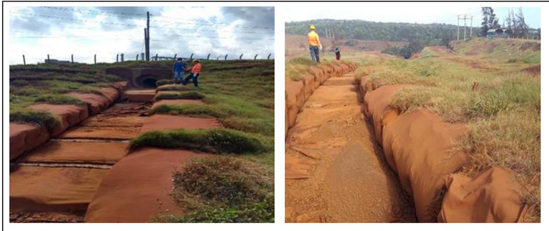
**Figura 4.3.** Método de Hidrobloques.
