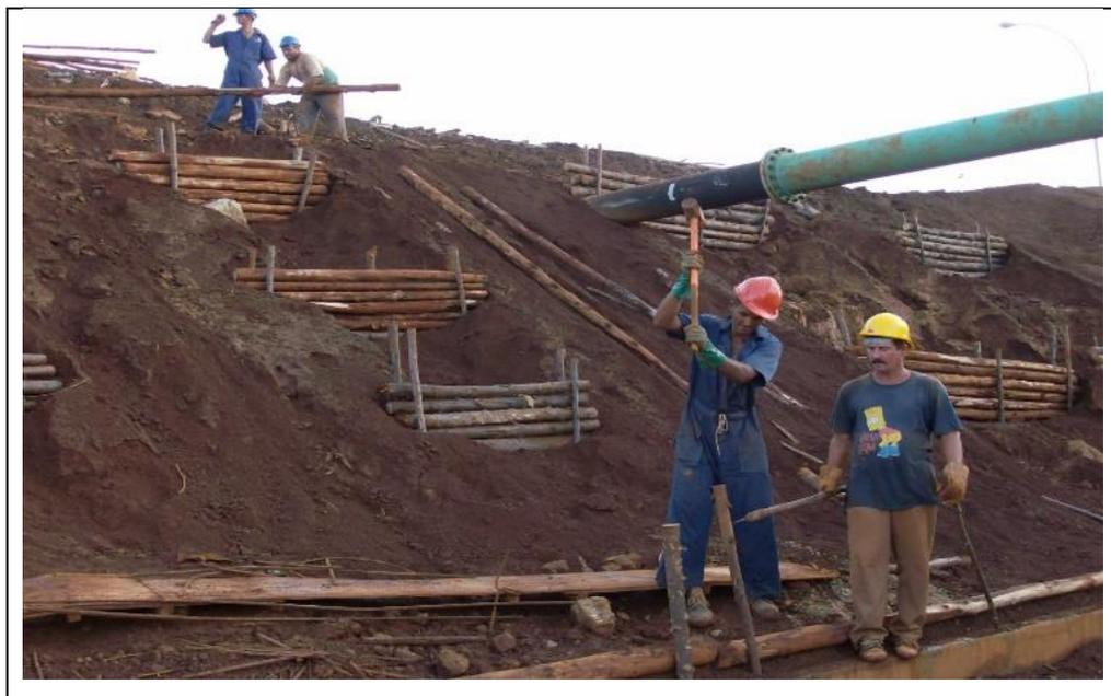
**Figura 4.27** Verificación de la aplicación de las técnicas de bioingeniería en áreas afectadas por la minería .
