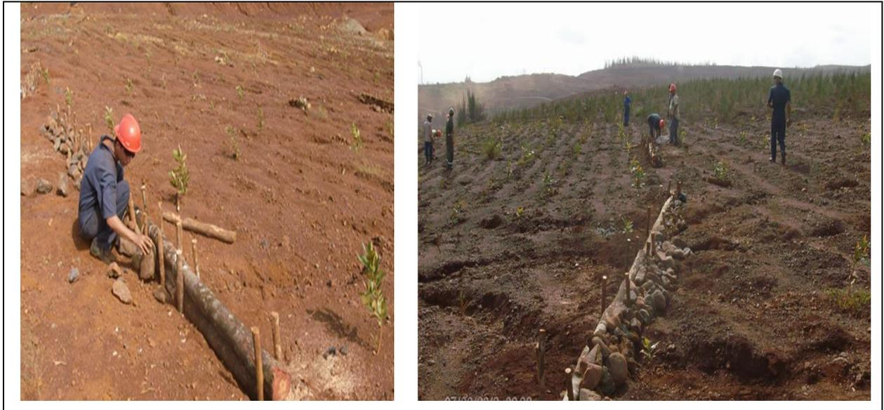
**Figura 4.22** Trabajos de mantenimiento en obras de bioingeniería para la estabilización de suelos minados en la empresa Moa Nickel S: A.
