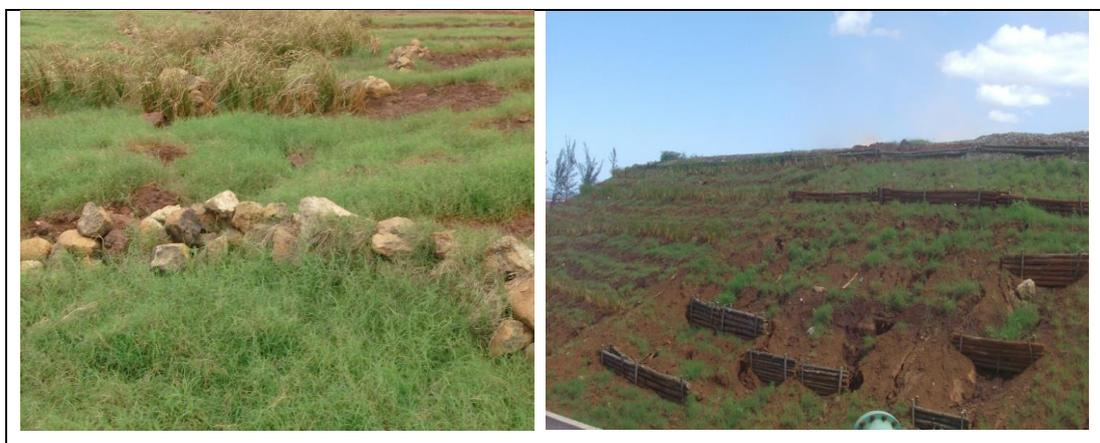
**Figura 4.19** Técnicas de bioingeniería intercalando con pastos y estaquillados de madera para estabilizar taludes en la minería.
