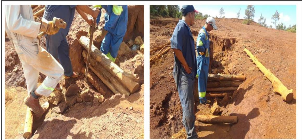
**Figura 4.7** Muros de postes de madera para estabilizar el talud y las cárcavas.
