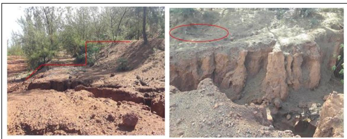
**Figura 4.6** Técnicas de estabilización con el método de terrazas (siembra de pinos y helechos).
