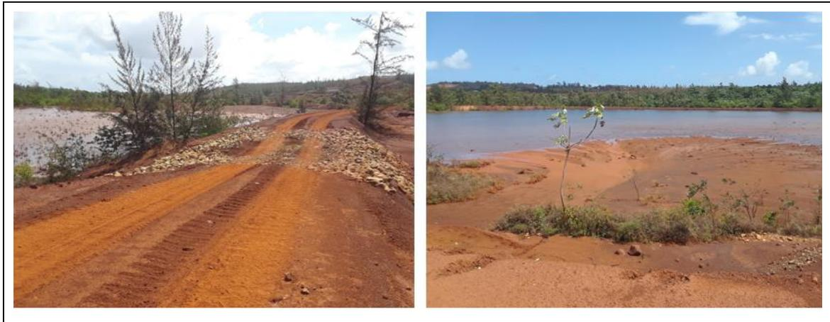
**Figura 4.13** Son un conjunto de obras que se diseñan en dependencia del avance de la minería, con el objetivo de mantener un control efectivo de la erosión y sedimentación dentro de las áreas que van a hacer minadas.
