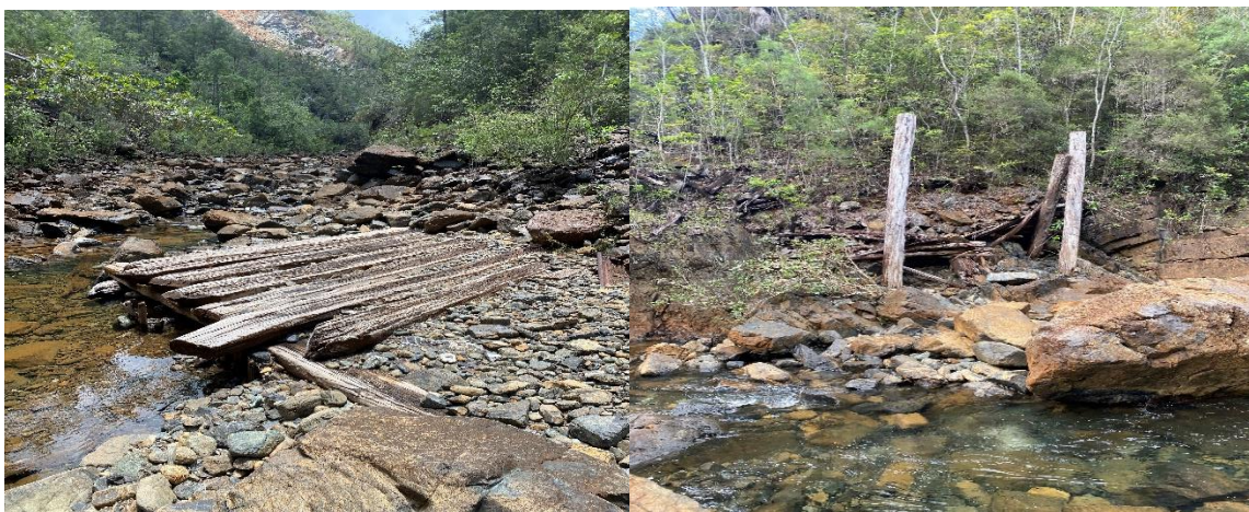
Figura17. Puente antiguo minero.
