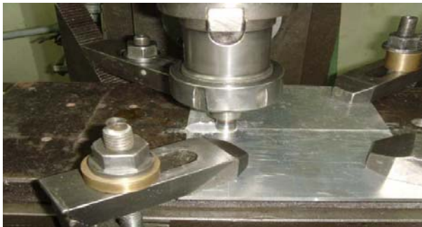
Figura 2.5. Instalación del proceso de soldadura a tope de la aleación de aluminio.
