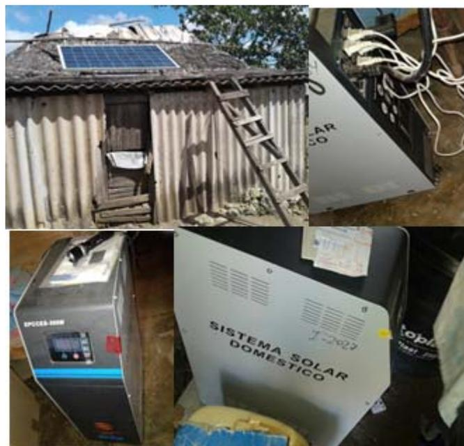
Figura 3.9 Sistema Solar Doméstico EPCCES-300M
