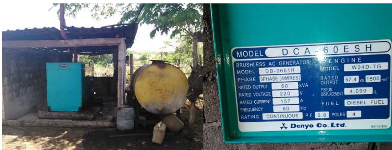
Figura 3.1. Grupo Electrónico instalado en el poblado
