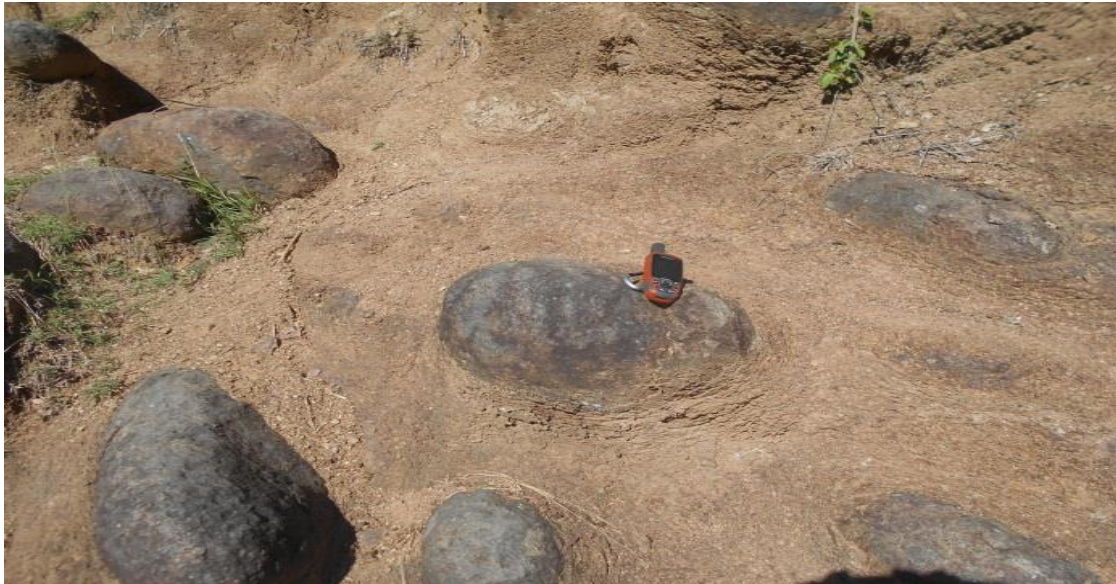
Figura 20: Corte del camino en Piñonal.
