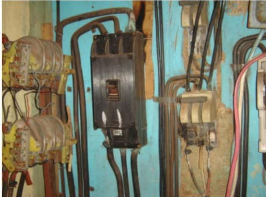
**Anexo 16: Estado de las cuchillas del panel principal del edificio 2.**
