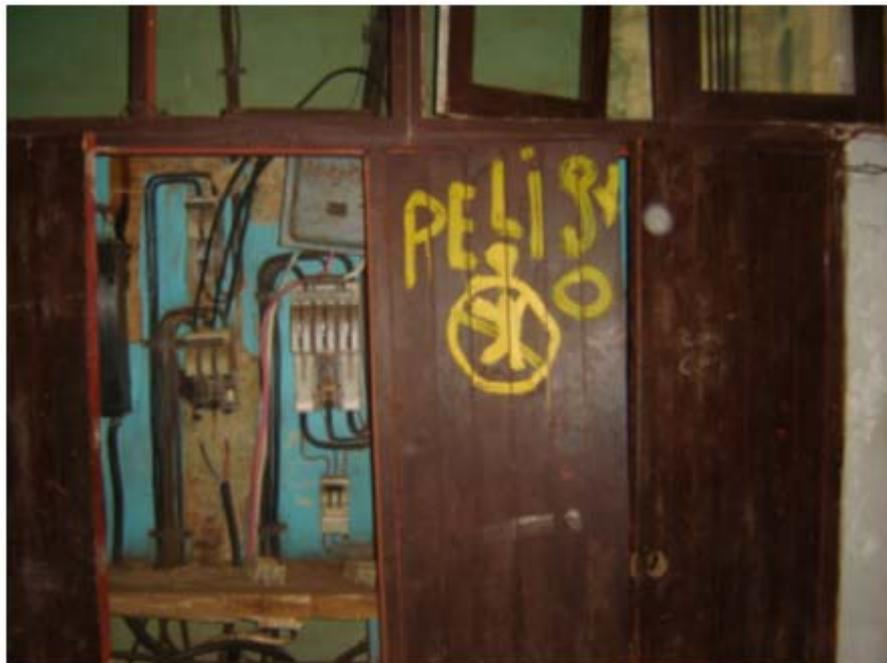
**Anexo 15: Estado de las cuchillas del panel principal del edificio 2.**
