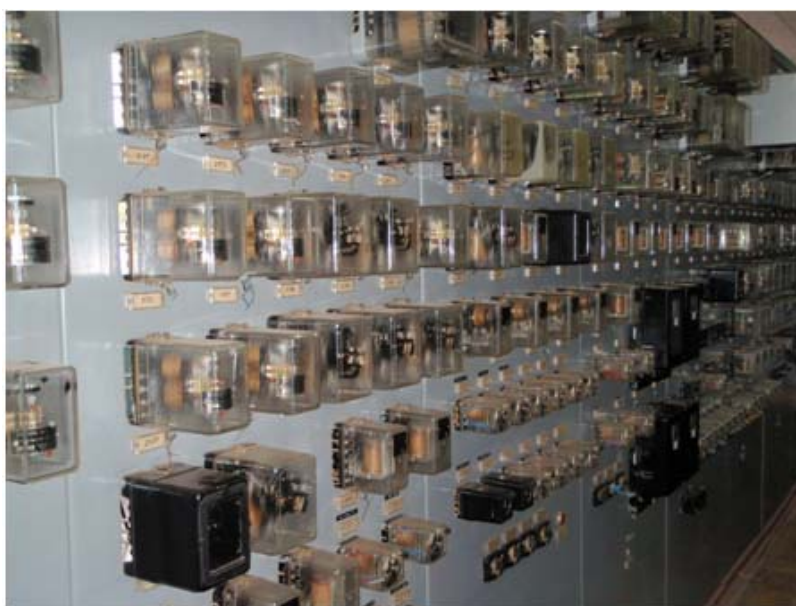
Fig. 1.2 relés de sobrecorriente.
