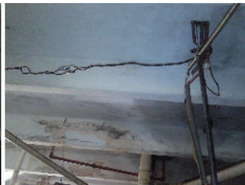
H) Tendedera que alimenta al cuarto #224.
