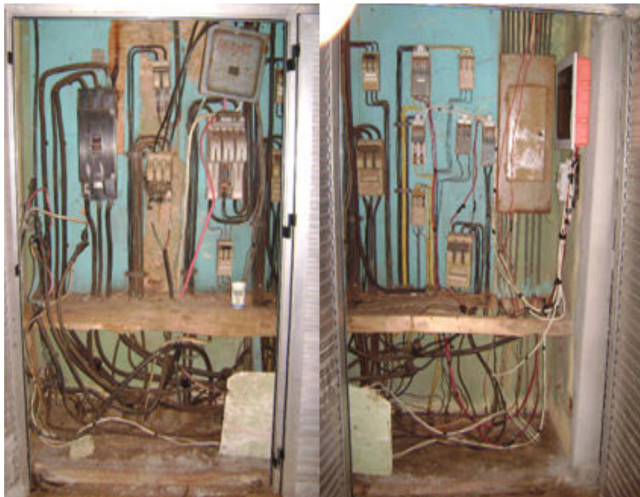
Estado actual del panel general del edificio2.
