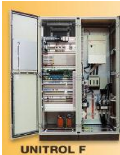
Fig.3.4 Sistema de excitación UNITROL F.
