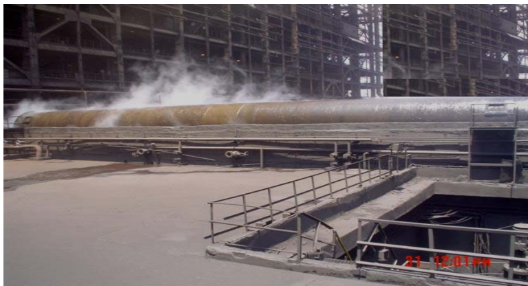
Figura 1.1. Instalación destinada para el proceso de enfriamiento.
