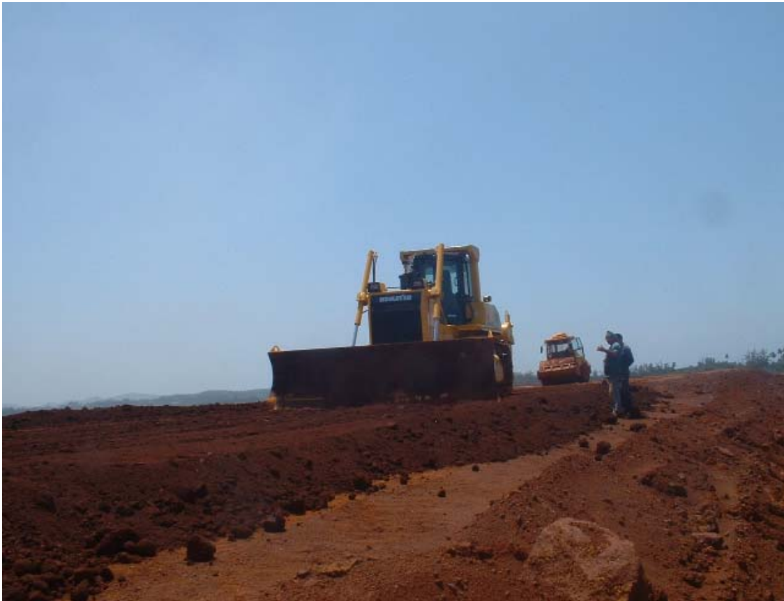
Figura 6. Capas para la formación de los diques.
