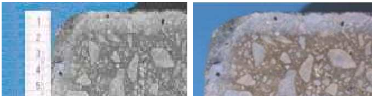
Figura 3.4. Profundidad de carbonatación revelada con solución de fenolftaleína al 1 %
