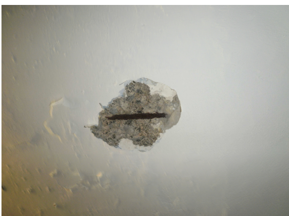
Anexo 4. Foto pared trasera del edificio # 4
