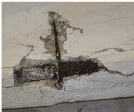
Anexo 3. Pasillo de la enfermería.
