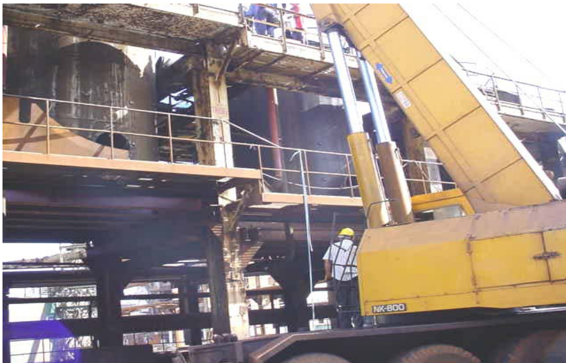
Vista lateral de la miniserie C de turboareadores durante la reparación
