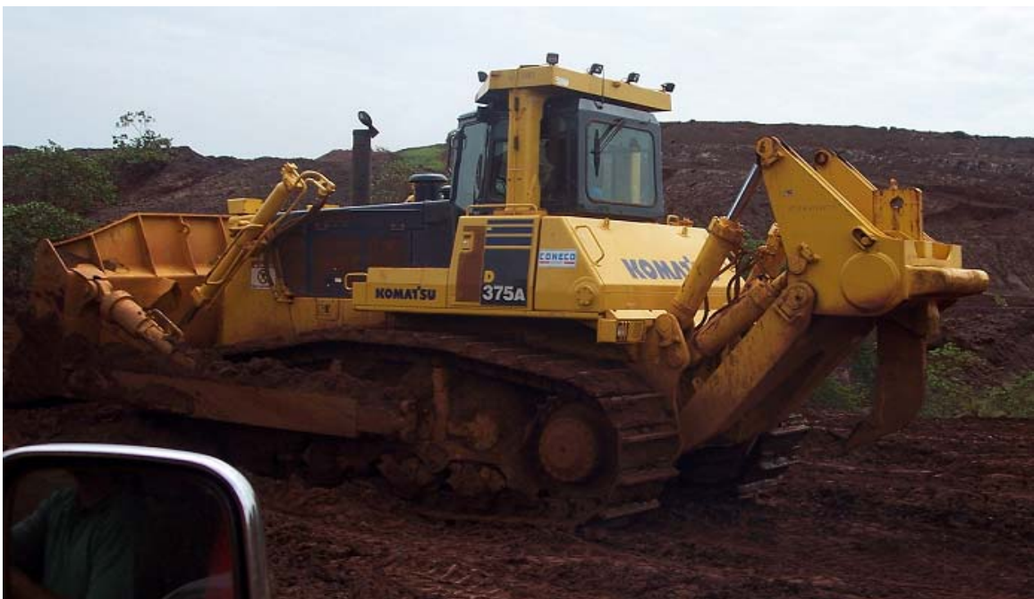
Figura-2. Bulldoser en el destape
