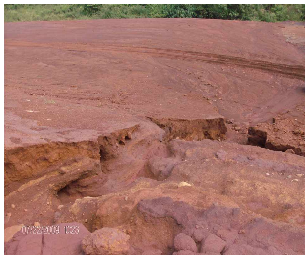
Fotos 10 y 11. Erosión en surcos y cárcavas en los diques de la presa de colas.
