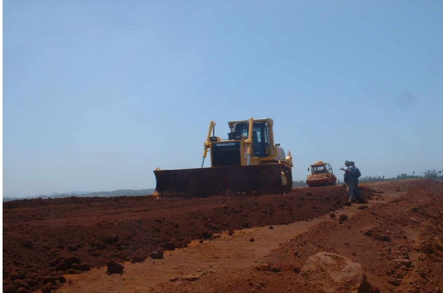
Foto 3. Conformación de las capas.
