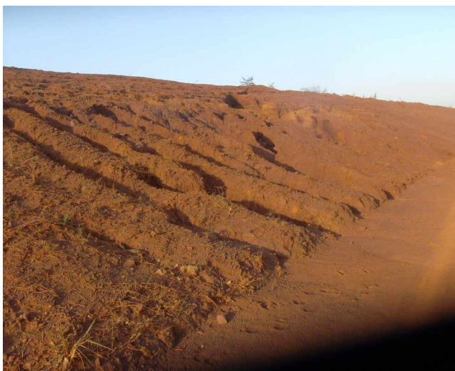
Fotos 10 y 11. Erosión en surcos y cárcavas en los diques de la presa de colas.
