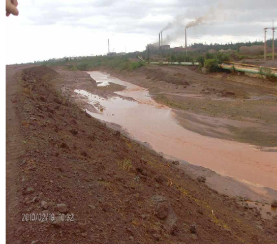
Fotos 5 y 6. Río Los Lirios: Alto grado de colmatación por sedimentos en el cauce.
