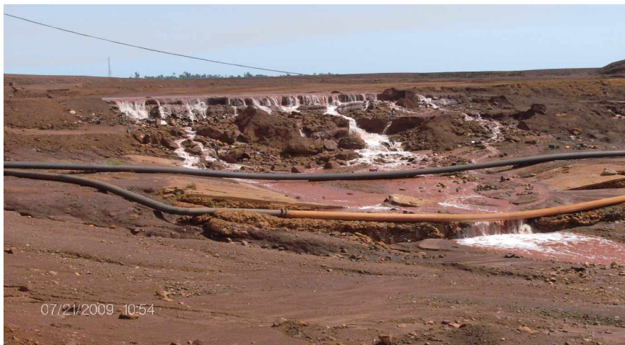
Foto 9. Rebosamiento de la presa de colas producido por intensas lluvias.
