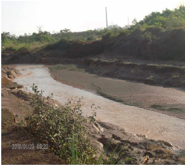
Fotos 7 y 8. Desviación del río Los Lirios para ampliación de la presa de colas
