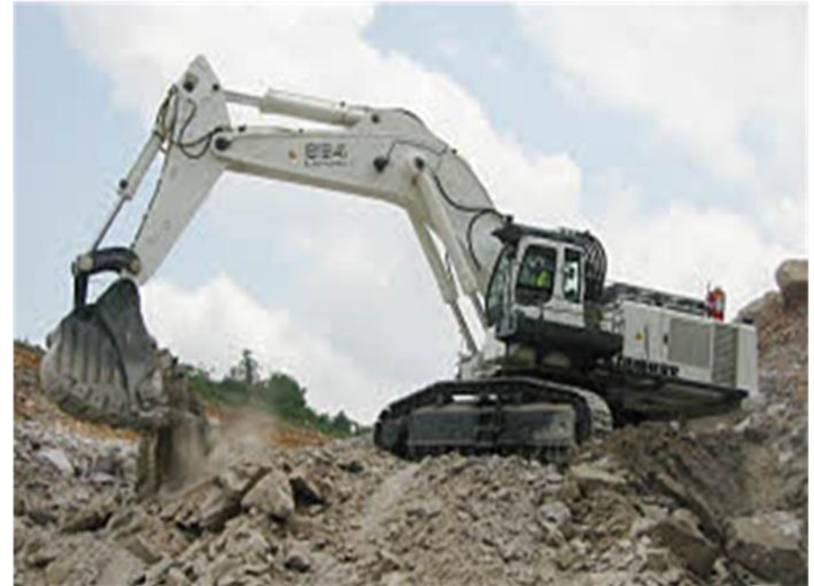
Retroexcavadora Liebherr R-984C
