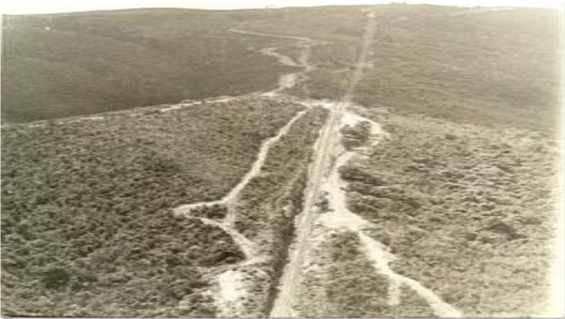
VISTA AEREA DE LOS PLANOS INCLINADOS
