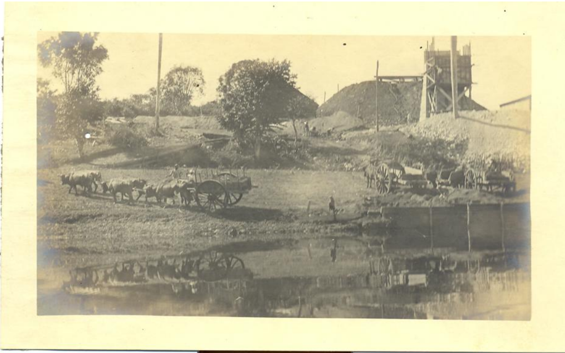
Ilustración 2. PRIMERAS FOTOS .1907 Construcción de puente sobre el Río Mayarí
