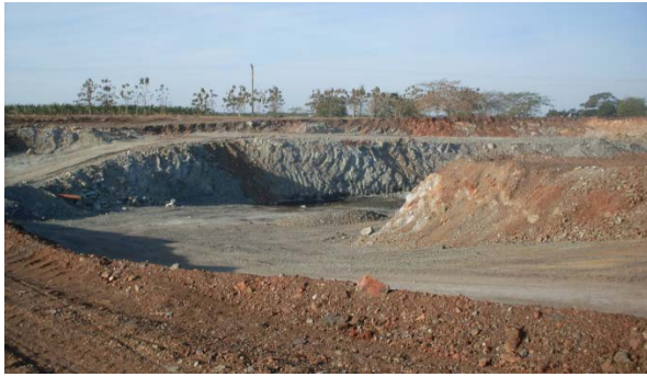
Foto.Nº.2. Avances por niveles, con su rampa de acceso.
