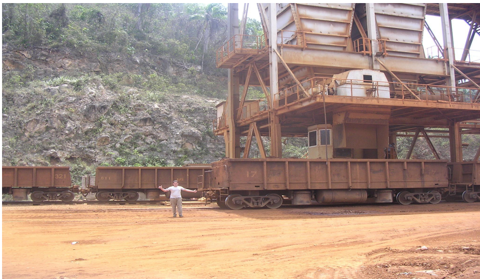
Vista del punto 4. Punto de descarga del transportador donde se llenan los vagones.
