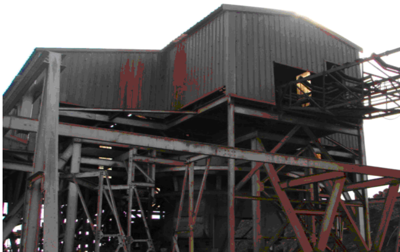
Luz Norte: Edificio de carga del Teleférico
