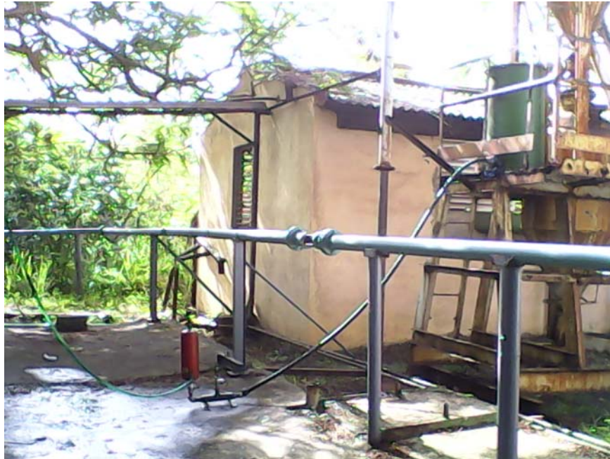
Figura 2.1. Esquema de instalación del ariete hidráulico monopulsor
