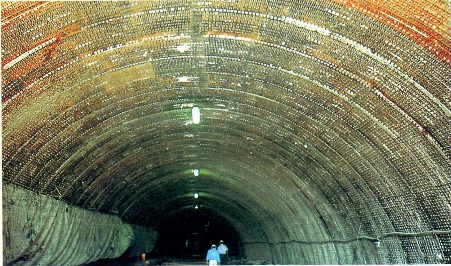
Figura 1.3 Túnel sostenido con chapa Bernold entre cerchas.
