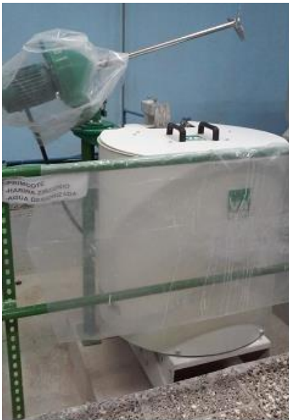
Figura 2.8 Tanques con la mezcla aglutinante.
