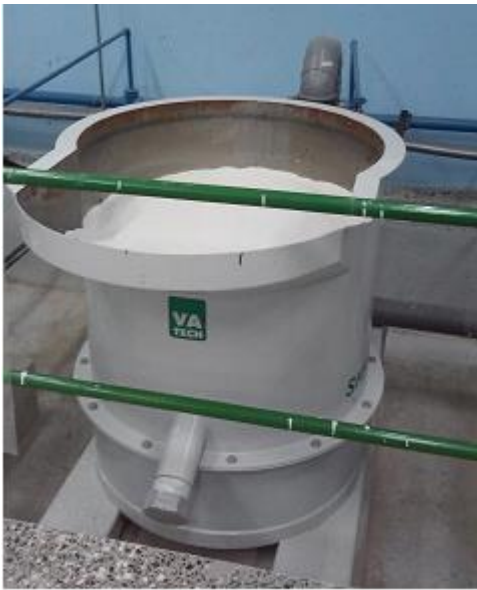
Figura 2.10 Bombo con efecto suspensión para arenas gruesas.
