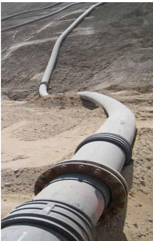
Figura 4.6. Red de tubería de polietileno del productor y distribuidor PEXGOL
