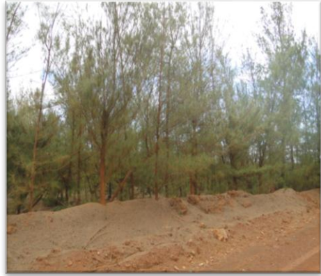
Mala conformación de las escombreras.
