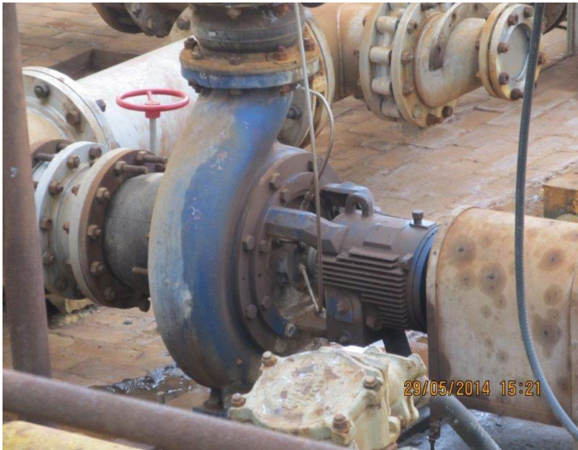
Anexo 1.4 Bomba accionada por motor en la planta Neutralización.
