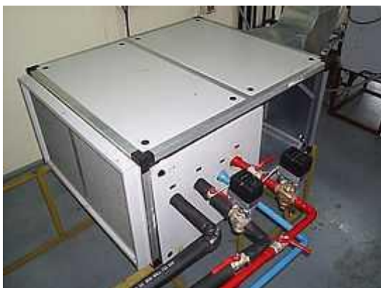
Figura.1.1. Unidad Manejadora de Aire sencilla.
