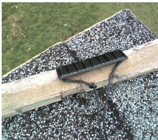
Figura 9: Foto celda empleada como sensor, en la instalación echa en el ISMM.
