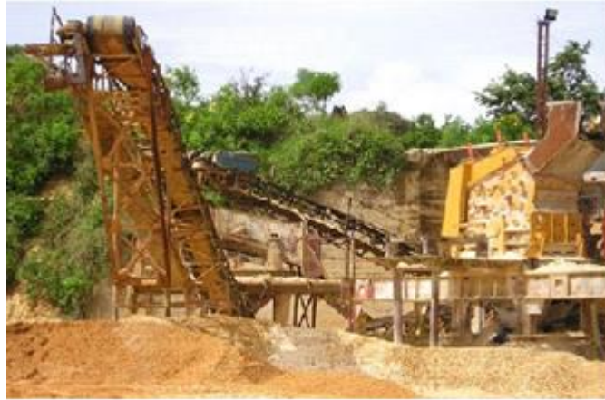
Foto 8. Molino de preparación mecánica
