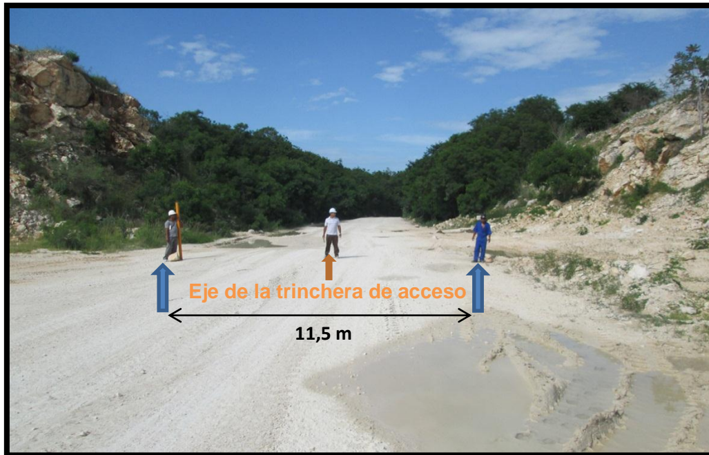
Fig. 3: punto de inicio de la trinchera
