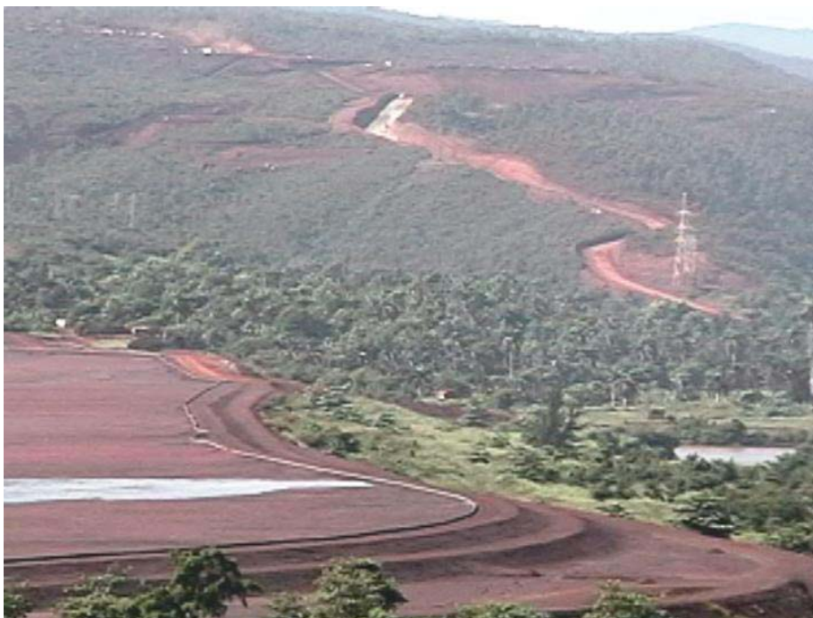
Ilustración 12 Vista del camino minero al yacimiento Moa Oriental y de la presa de colas, la comunidad se encuentra entre ambos.
