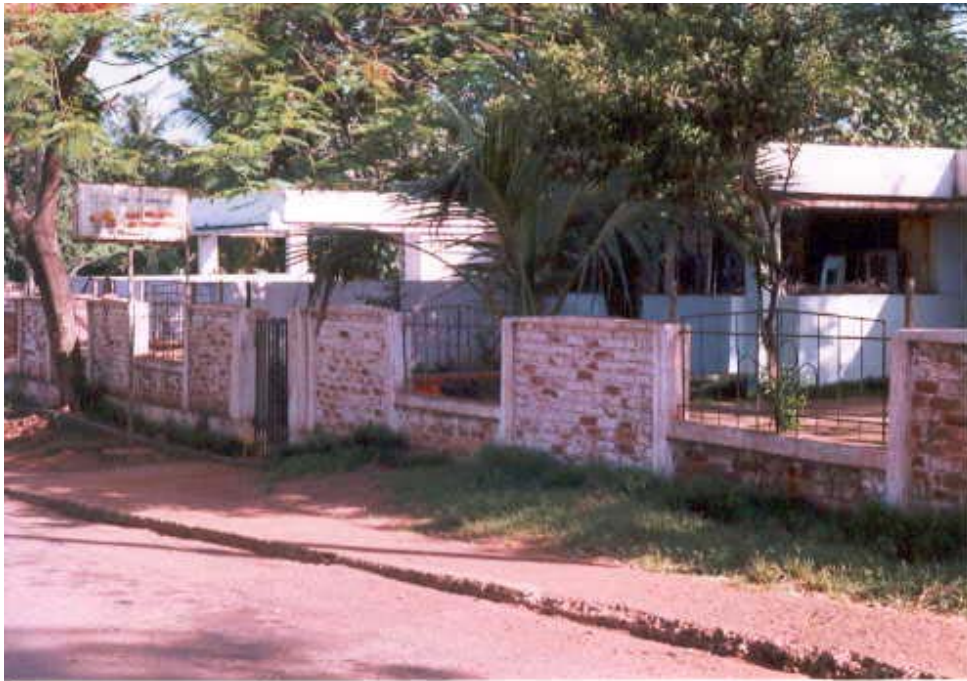
Ilustración 28 Circulo Infantil en el Reparto Rolo Monterrey
