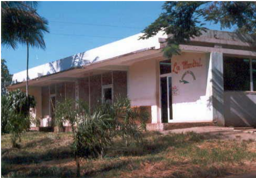
Ilustración 26 Bodega ubicada en el Reparto Rolo Monterrey
