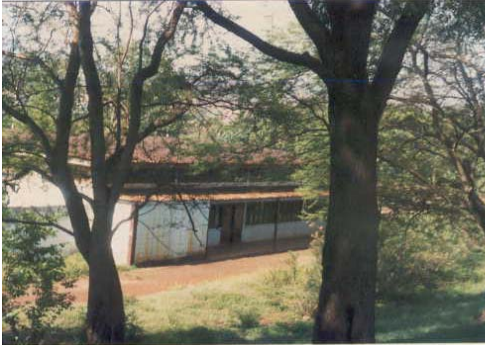
Ilustración 27 Secundaria Básica en el Reparto Rolo Monterrey
