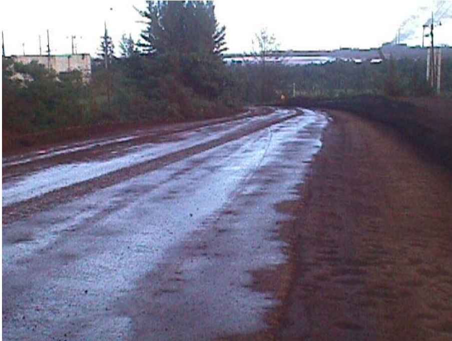
Ilustración 13 Vía de acceso a La Veguita, regada ahora permanentemente para atenuar el polvo generado por la transportación del mineral desde el yacimiento Moa Oriental
