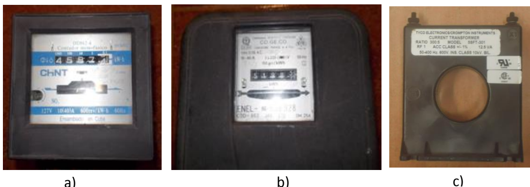
Fig. 2.13. Instrumentos fijos en el puesto del ISMMM a) Contador de energía activa monofásico. b) Contador de energía activa trifásico. c) Transformador de corriente
