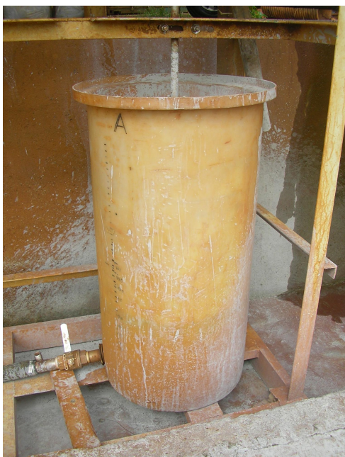
Figura. 10. Tanque agitado de la instalación experimental
