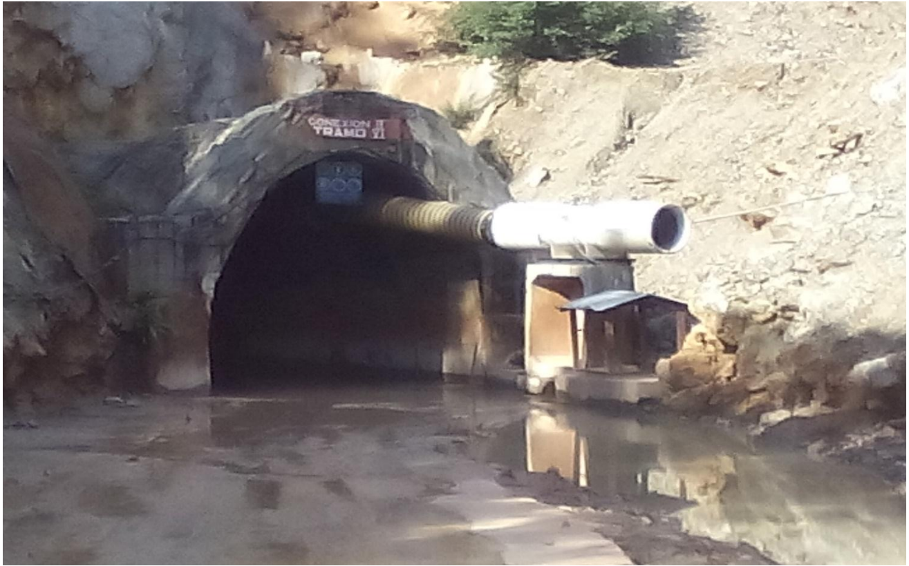
Figura 11. Vista del túnel Levisa - Mayarí Tramo V
