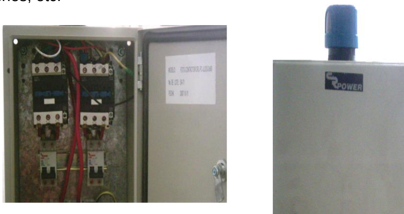
Figura No.3.17. Interruptor fotoeléctrico
