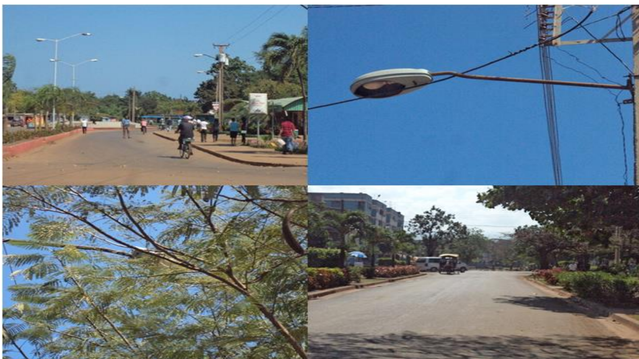
Figura N°2.4: Muestra de las deficiencias del sistema de iluminación.
