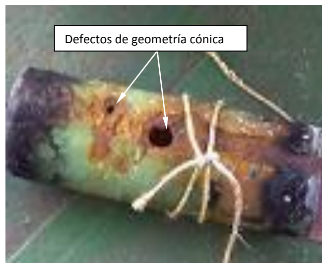
Figura 3.2. Defectos en tubería de 4" (101,6 mm)
