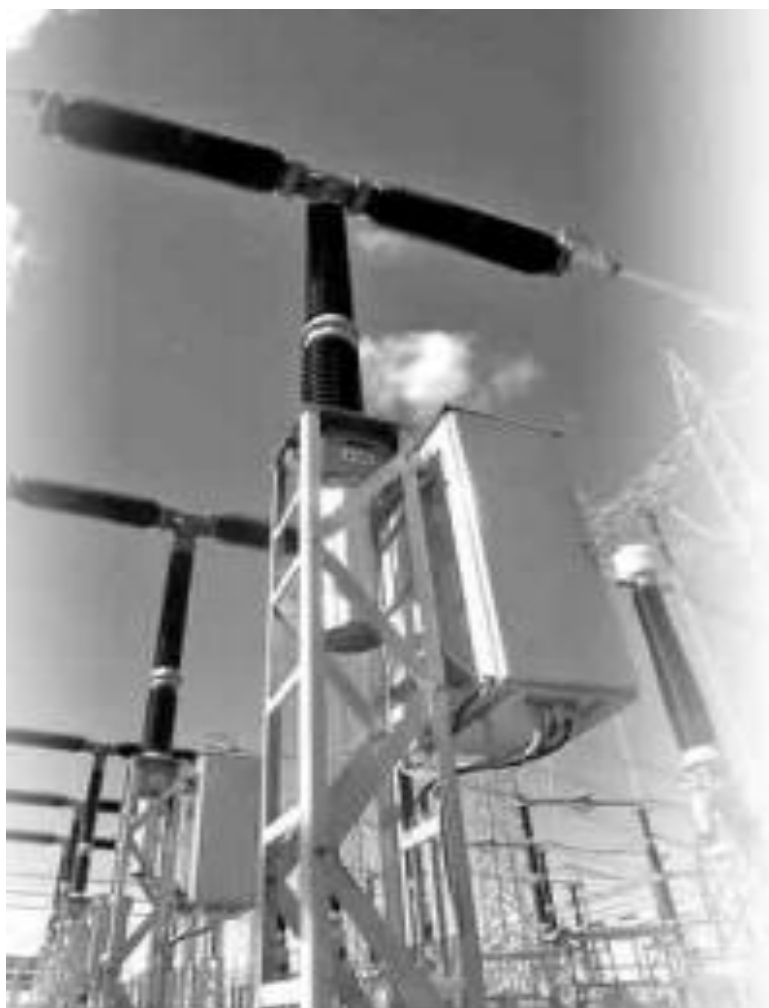
Interruptor de Exafloruro de Sodio (SF6) Nulec
