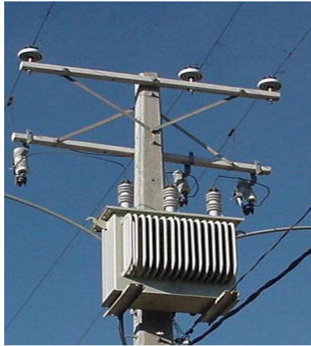
Figura 1.1 Transformadores de distribución.
