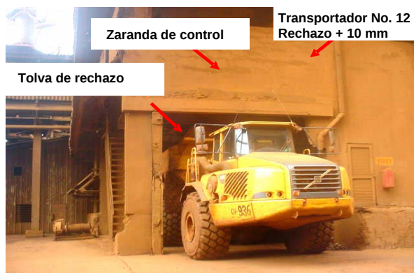
Fig. No. 9: Carro donde se descarga la tolva de rechazo
