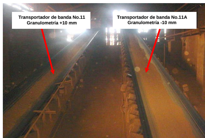
Fig.No. 7: Detalle de la situación de las correas a la descarga de los secaderos
