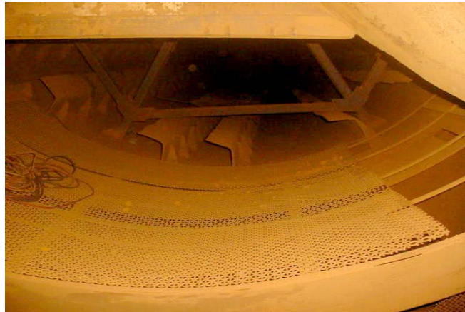
Fig. No.6: Montaje del Tromell en la descarga del secadero
