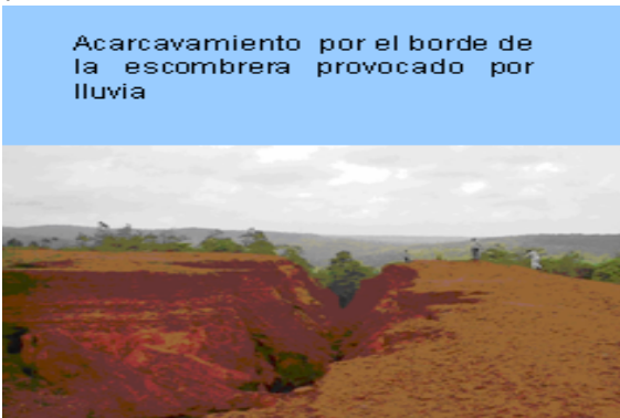
Fig 3: Derrumbes en escombrera por acaravamiento provocado por la lluvia
