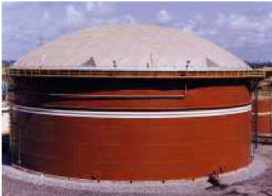
Techo domo con techo flotante interno
